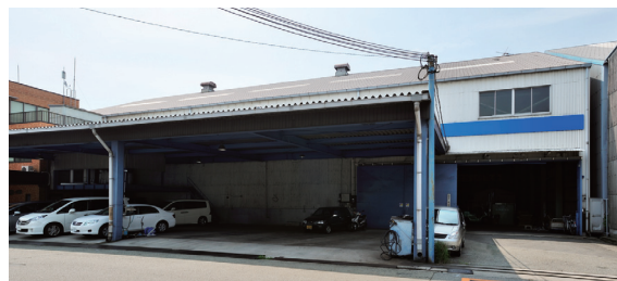
鉄骨造亜鉛メッキ鋼板葺平家(面積 1,165.11㎡)
